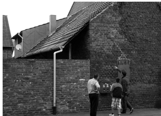
Einschußlöcher sind heute noch an der Giebelwand des Bauernhofes zu sehen, in dem Jazenko Prokofi kurz vor Kriegsende durch Granatenbeschuß umkam
